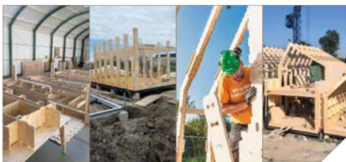
Bouwplaats Stripmaker, foto's WikiHouseNL (ontwerpburo MULLER)
