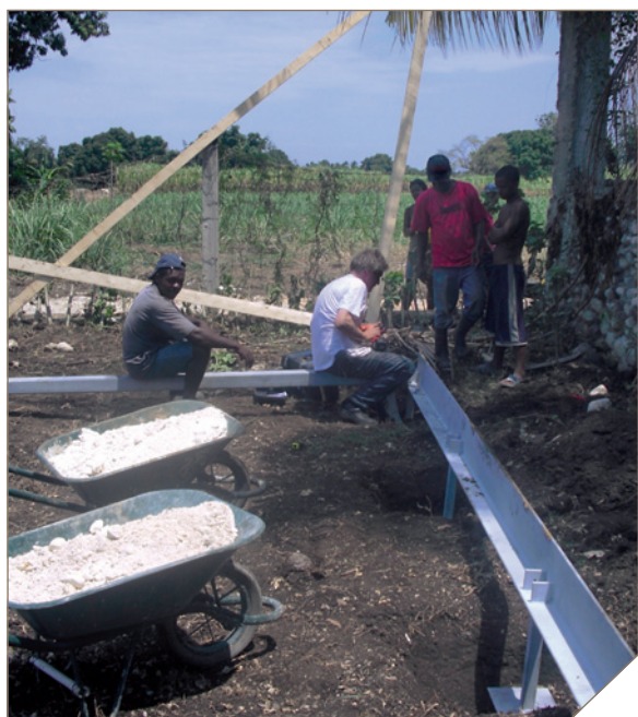
Foto op Haïti genomen na de aardbeving in 2010 om een huisje te bouwen. Bezigt met de fundering.
