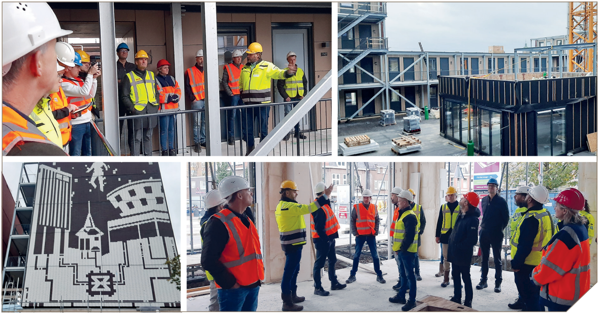
Op de bouwplaats.
