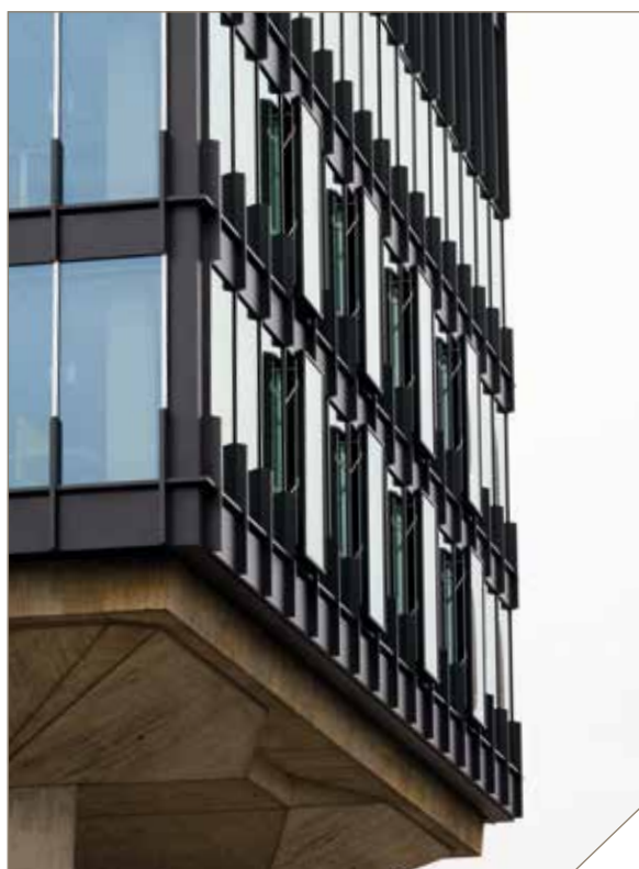
PAF-ramen in de gevel (foto: Bart van Overbeeke Fotografie).
