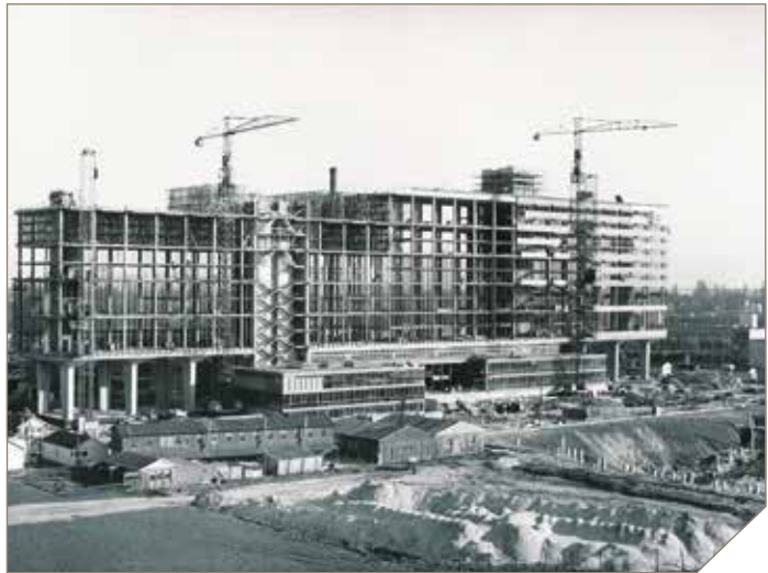
Hoofdgebouw TU/e in aanbouw, circa 1961 (foto: Fotoarchief TU/e).
