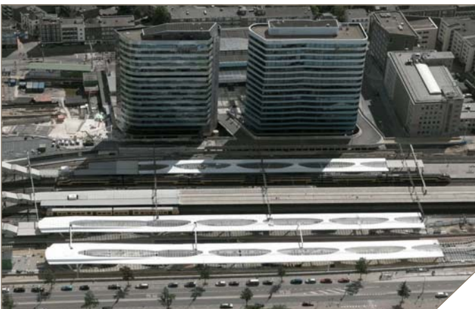
Fig. 1 Realisatie van het treinstation in Arnhem binnen het project 'Sporen in Arnhem'.
