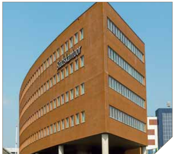
Gesloten gevel met openingen.
