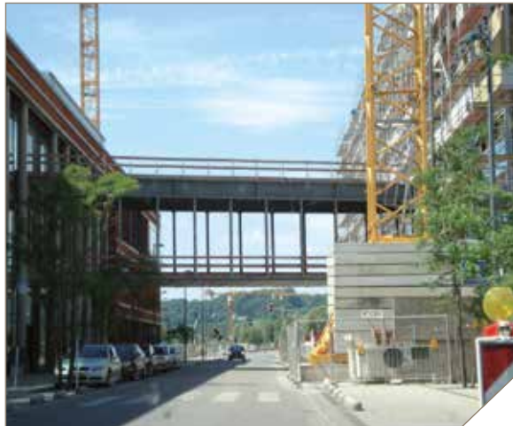
Brug tussen Belval Plaza I en II.
