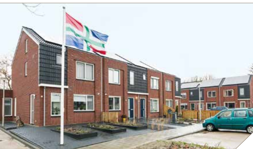
Aardbevingsbestendige woningen, Loppersum.
