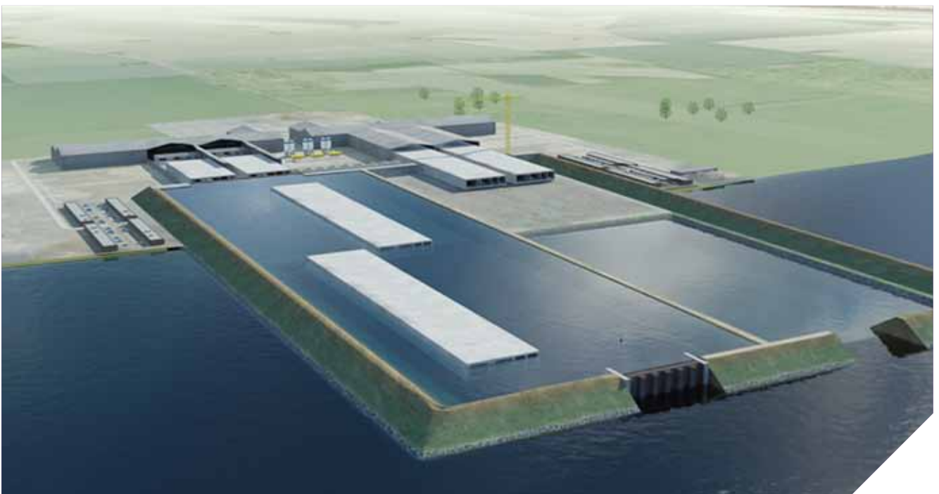
Fig. 1: Bouwplaats tunnelementen (bron: Femern A/S)
