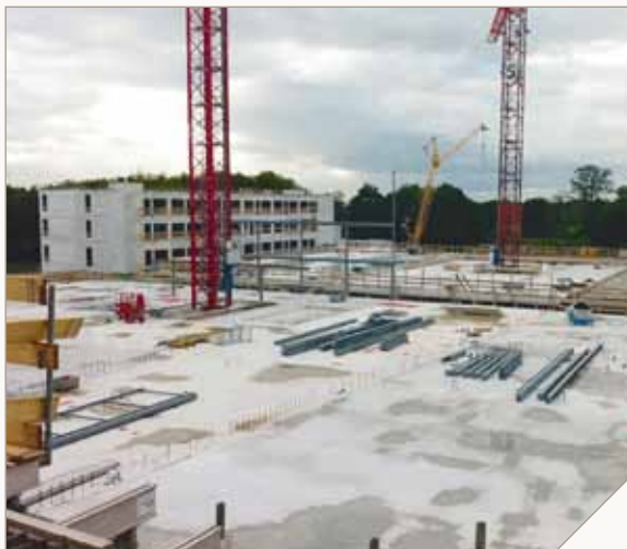
Fig. 1. Meander Medisch Centrum in aanbouw.
