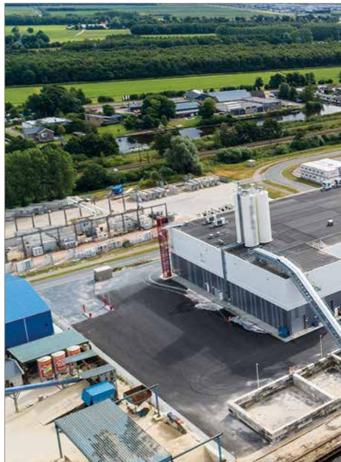
De bouw van de fabriek startte in het najaar van 2020. Het hoogste punt de fabriek operationeel zijn en de eerste woningen produceren.
