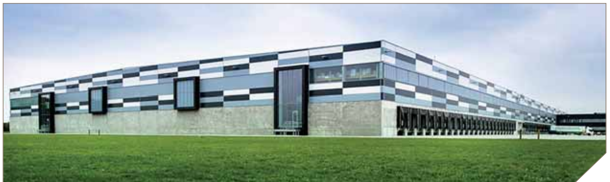
Distributiecentrum LIDL in Oosterhout.
