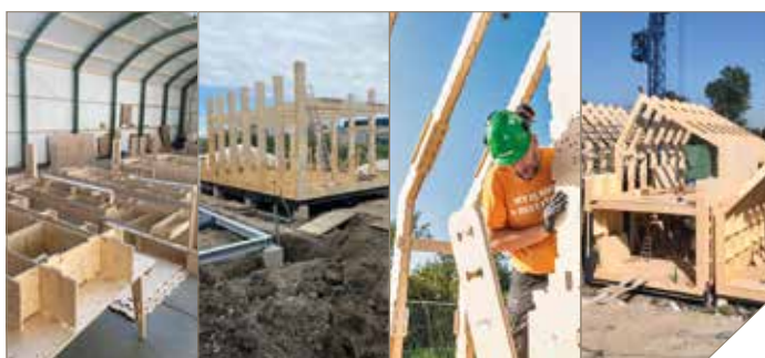
Bouwplaats Stripmaker, foto's WikiHouseNL (ontwerpburo MULLER)
