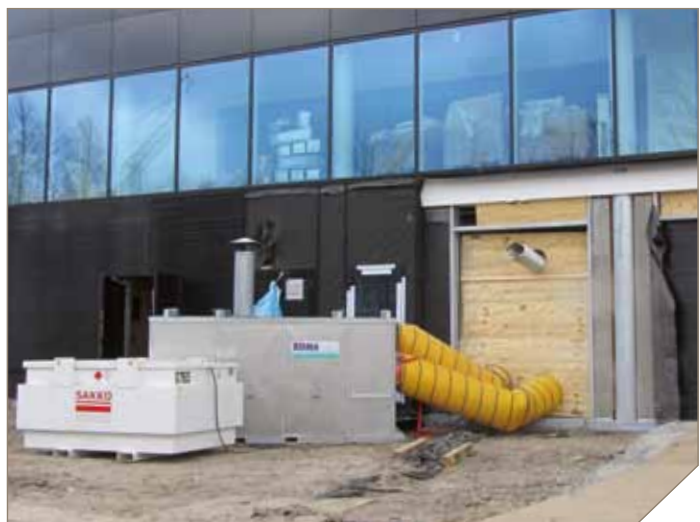
Fig. 1 Inzet van een olieachel voor de tijdelijke conditionering.
